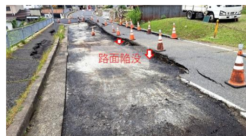
図6. 道路陥没
