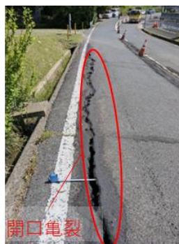
図5. 開口亀裂
